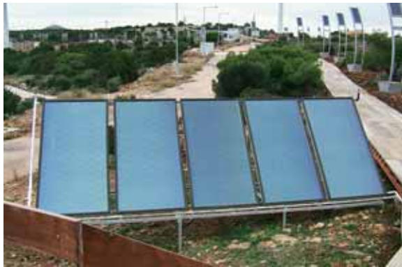
Πάρκο Ενεργειακής Αγωγής ΚΑΠΕ-Μονάδα Ηλιακού Κλιματισμού με τη τεχνολογία αφύγρανσης-εξάτμισης
