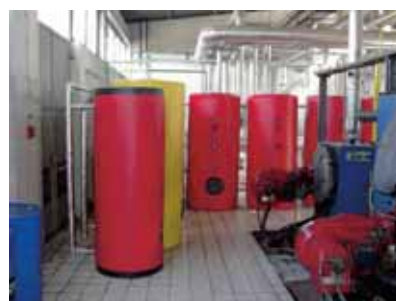
Εγκατάσταση Ηλιακού Θερμικού Συστήματος για ζεστό νερό χρήσης, επιφάνειας 140 m 2 ηλιακών συλλεκτών, στην Κλινική Αποκατάστασης του Ερυθρού Σταυρού Αρμενίας στο Ερεβάν
