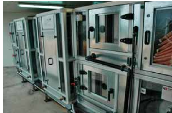
Πάρκο Ενεργειακής Αγωγής ΚΑΠΕ-Μονάδα Ηλιακού Κλιματισμού με τη τεχνολογία αφύγρανσης-εξάτμισης
