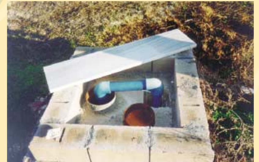
Η γεωθερμική πηγή - περιέχει μεταλλικό νερό 52°C στο γεωθερμικό σύστημα θέρμανσης του Ξενοδοχείου EOT στη Τραϊανούπολη, Έβρου
