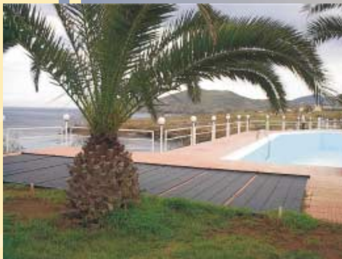
Πλαστικοί συλλέκτες (32 τ.μ) σε ανοιχτό χώρο κοντά στην εξωτερική πισίνα του ξενοδοχείου «Euroora» στη Κρήτη
