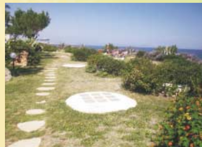
Οι φωταγωγοί στη φυτεμένη οροφή του ξενοδοχείου EL GRECO στο Ρέθυμνο, Κρήτης
