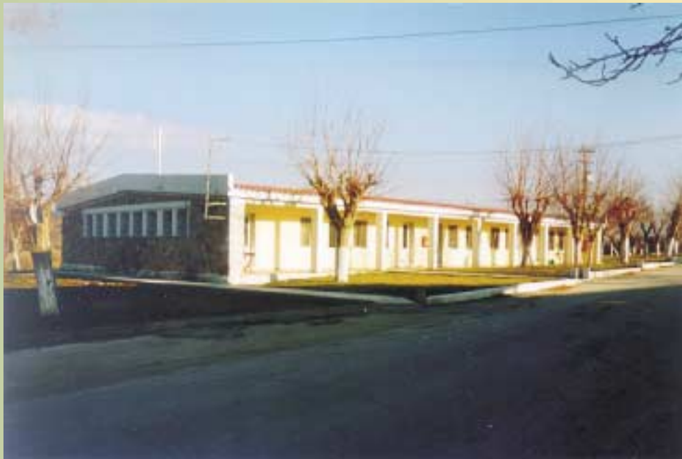
Ξενοδοχειακό συγκρότημα EOT στην Τραϊανούπολη, Έβρου: το ενδοδαπέδιο σύστημα θέρμανσης (ισχύος 400 kW) τροφοδοτείται με ζεστό νερό γεωθερμικής πηγής (52°C)
