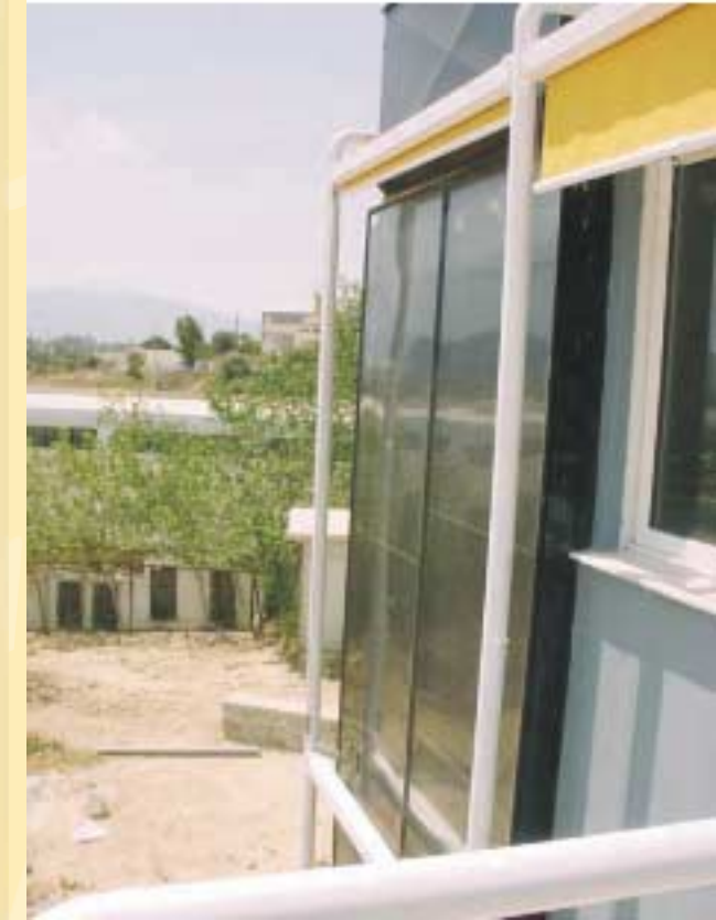
Οι ηλιακοί συλλέκτες στην νότια πρόσοψη του κτιρίου γραφείων του ΚΑΠΕ στο Πικέρμι, Αττικής
