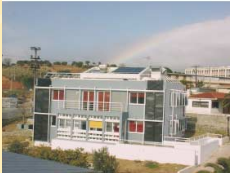
Ηλιακοί συλλέκτες αέρος στη νότια πρόσοψη του κτιρίου γραφείων του Κέντρου Ανανεώσιμων Πηγών Ενέργειας (ΚΑΠΕ) στο Πικέρμι
