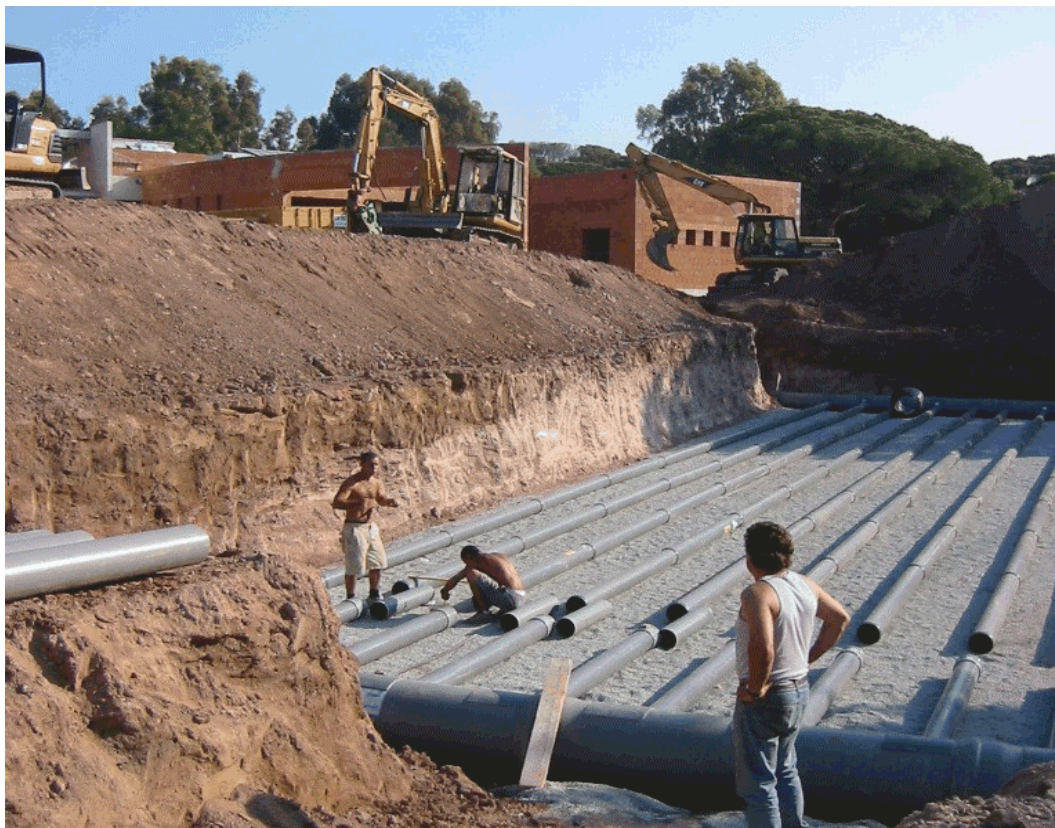
Εικόνα 31. Εγκατάσταση εναλλακτών θερμότητας αέρα-εδάφους. 79
